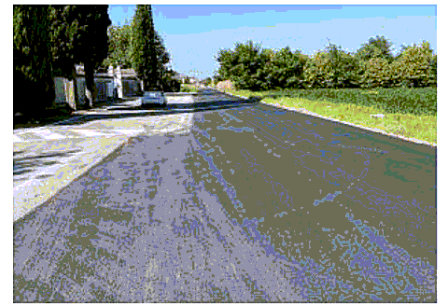
Basta buche L'asfaltatura di una strada comunale
