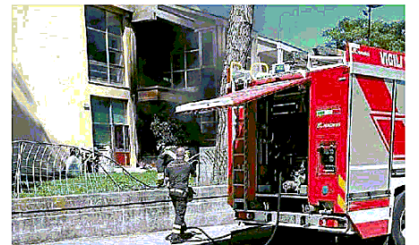
RIFIUTI IN FIAMME L'intervento dei pompieri nel plesso scolastico
