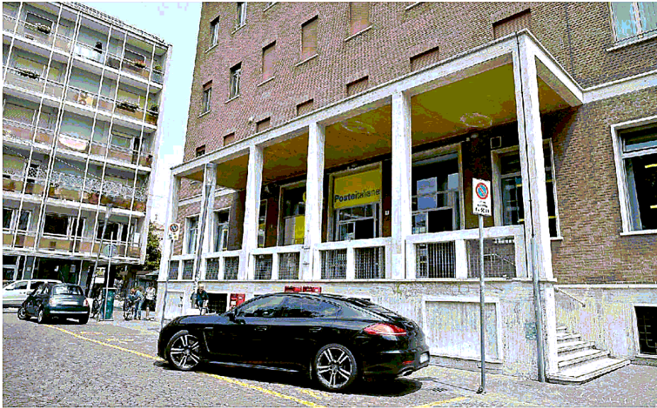
PIAZZALE DONATORI DI SANGUE L'ufficio centrale di Poste Italiane "isolato" per tutta la mattinata di ieri a causa del blackout
