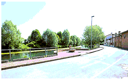
L'area interessata dai lavori di protezione ambientale a Fiume Piccolo
