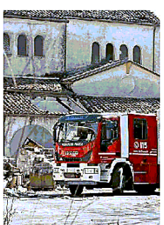
A FIUOCO Distrutto dalle fiamme l'ex ospedale psichiatrico
