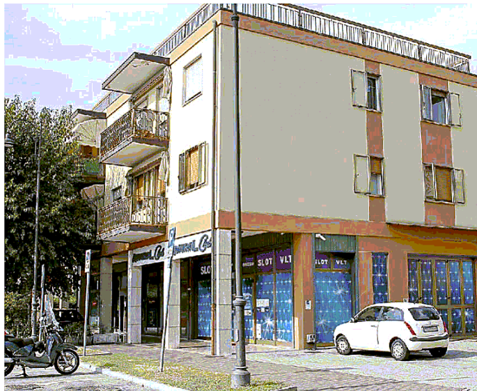
SPINEA La sala slot di via Roma presa di mira dai malviventi nel settembre del 2019
