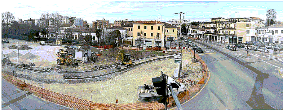
PIAZZA E ROTATORIA Il cantiere su via Roma visto dall'alto
