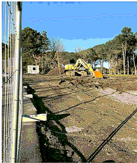
NEPI Cantiere per la nuova rotatoria
