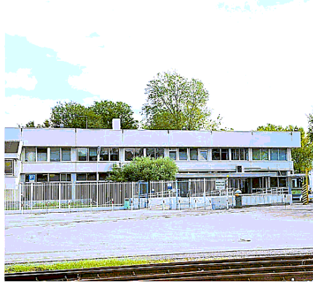
L'Alcoa di Fusina dove si è verificato l'incidente
