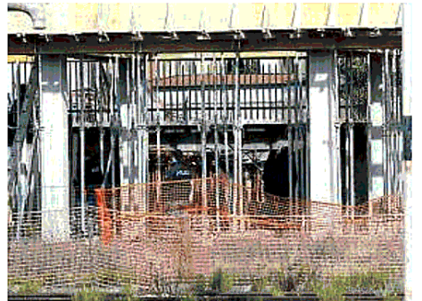
IL CANTIERE L'intervento delle forze dell'ordine dopo la tragedia
