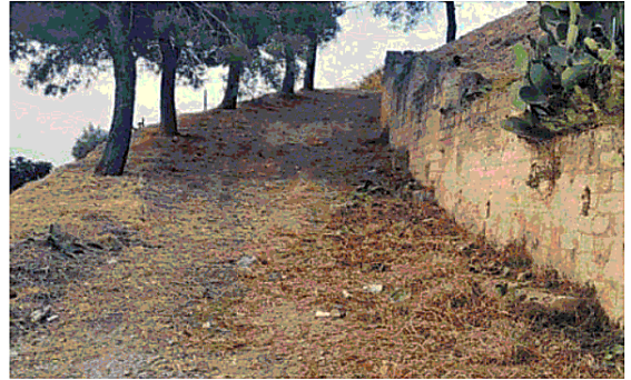
Una delle zone già completamente ripulite
