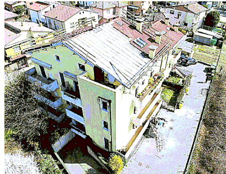
Lavori di riparazione al tetto del caseggiato
