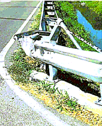
Il guardrail incurvato
