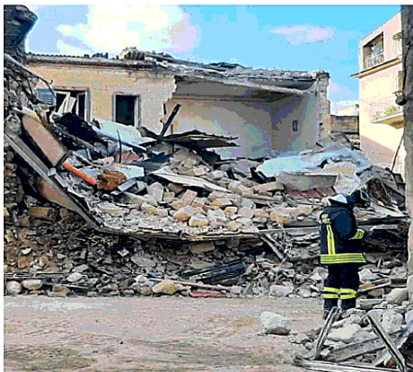
Ravanusa. Una delle abitazioni distrutte dall'esplosione
