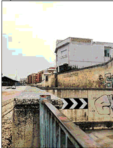
Il sottopasso della stazione di Trani sarà prolungato
