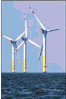
Parco eolico a mare
